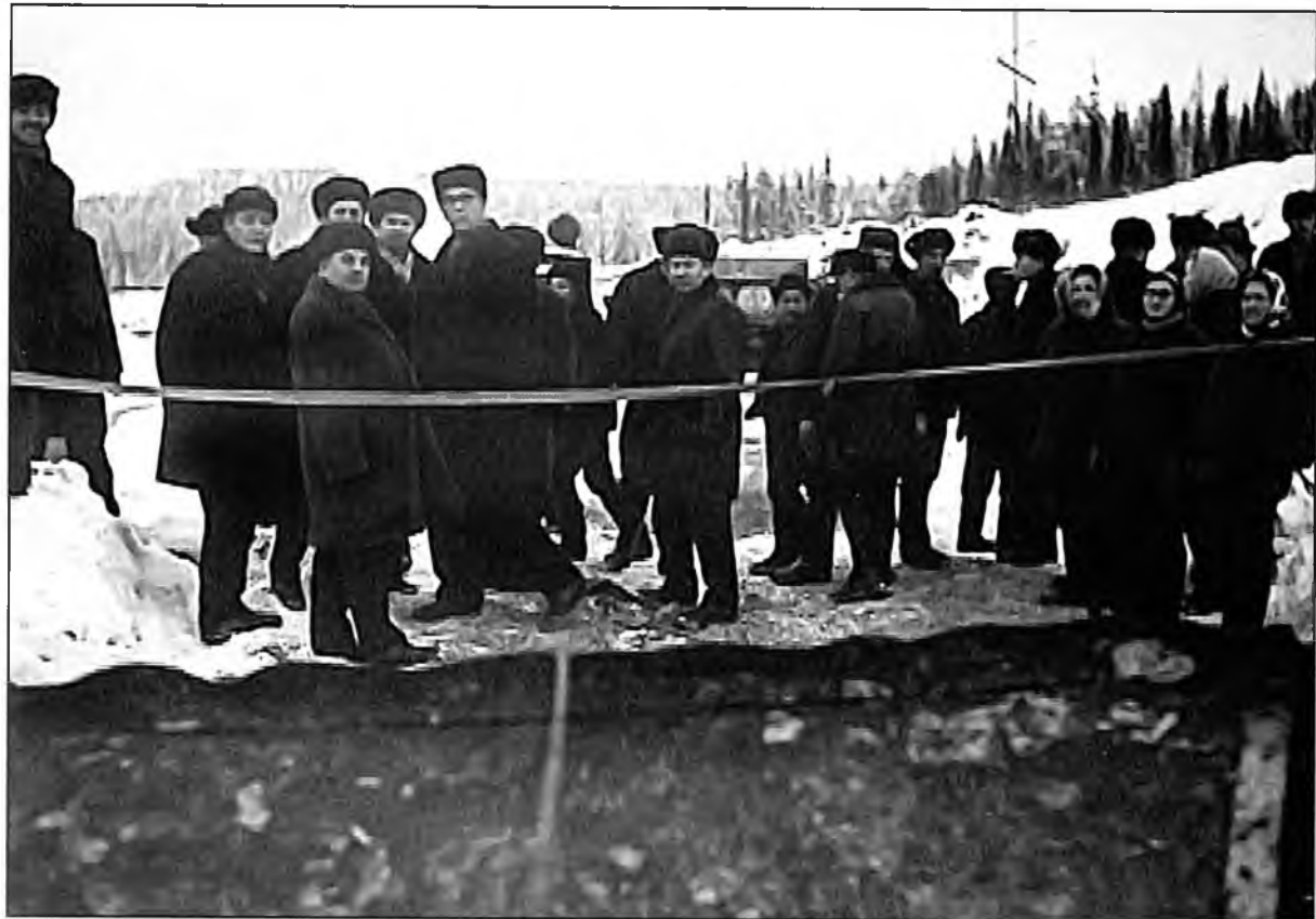
А. И. Сухачев на начале земляных работ на строительстве АБОФ. 1972 г.
