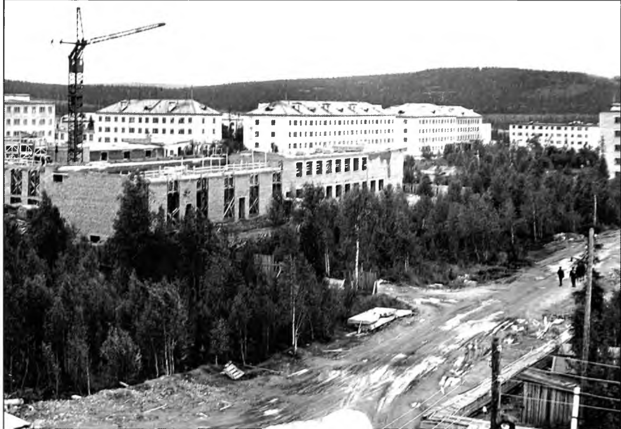
Строительство городского Дворца культуры. 1966 г.
