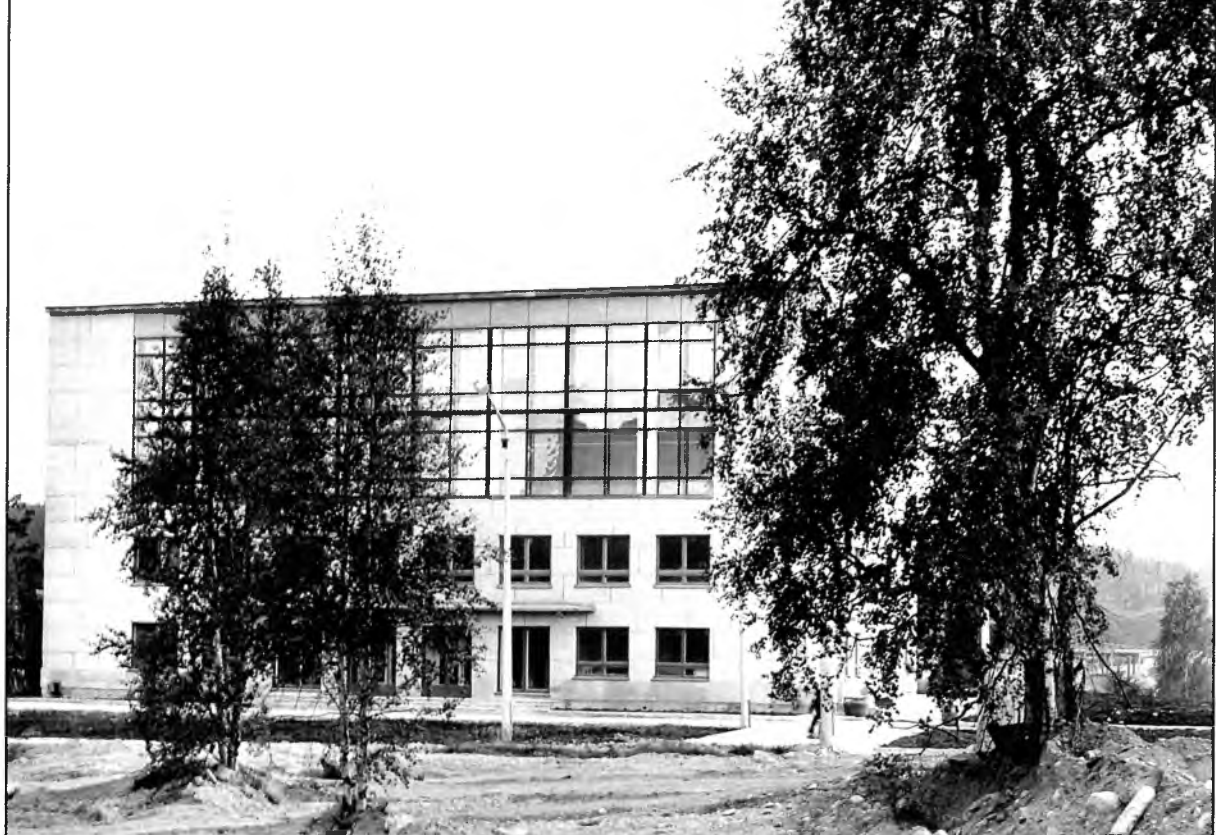
В 1973 году сдан в эксплуатацию бассейн
