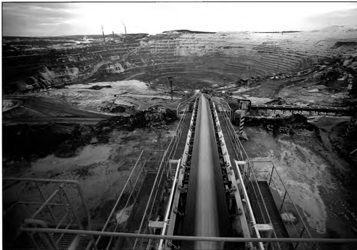
Конвейер ЦПТ транспортировки скальной вскрыши — и сегодня единственный на Северо-Западе
