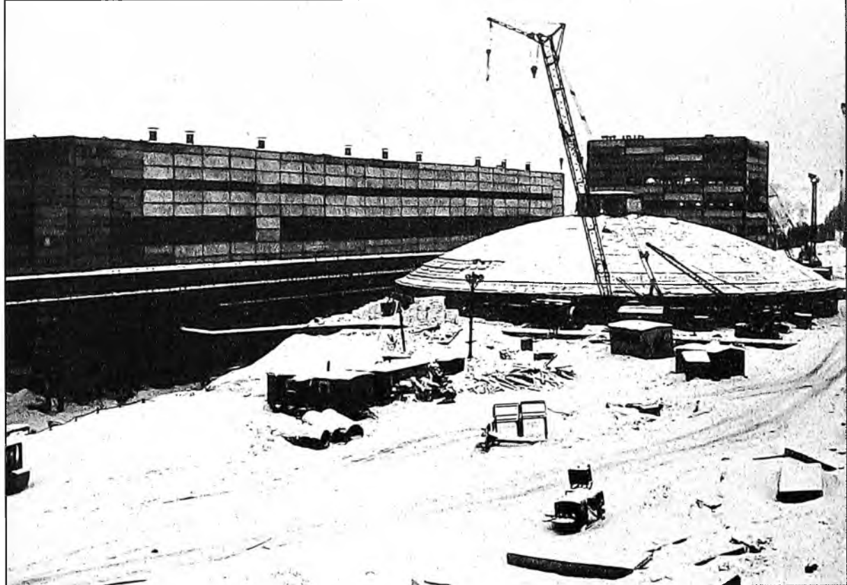
Завершение строительства сгустителя АБОФ
