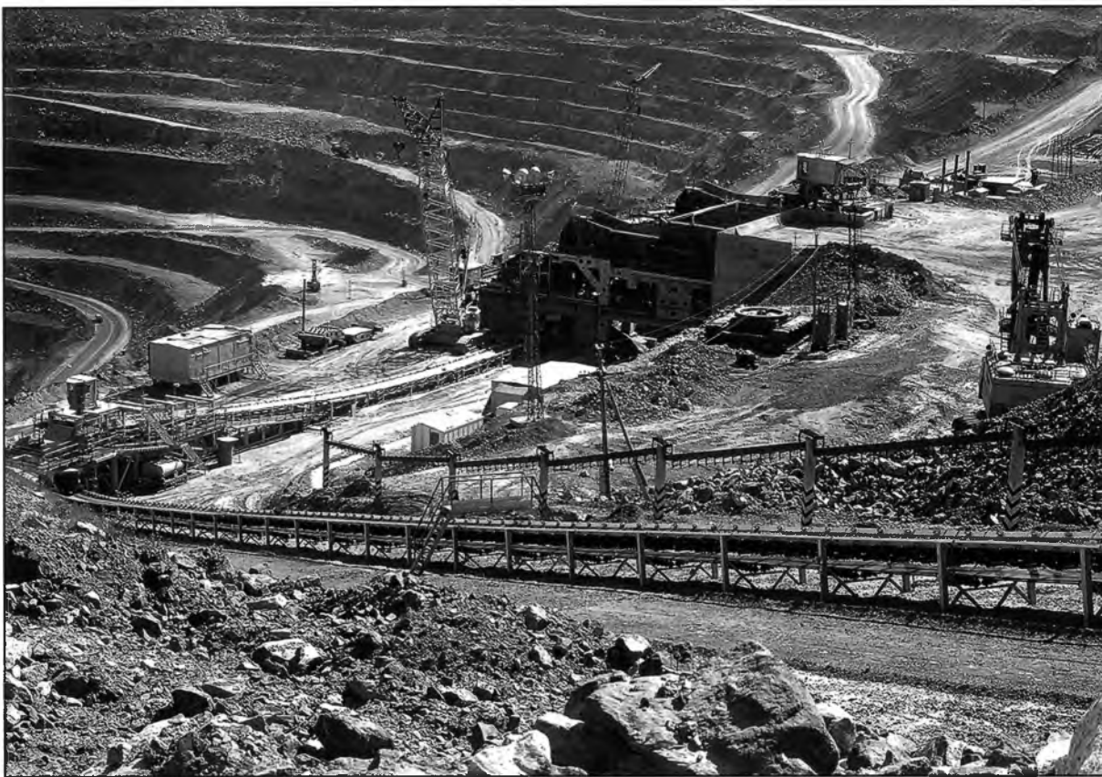
Дробильно-перезгрузочный узел циклично-поточной технологии транспортировки скальной вскрыши
