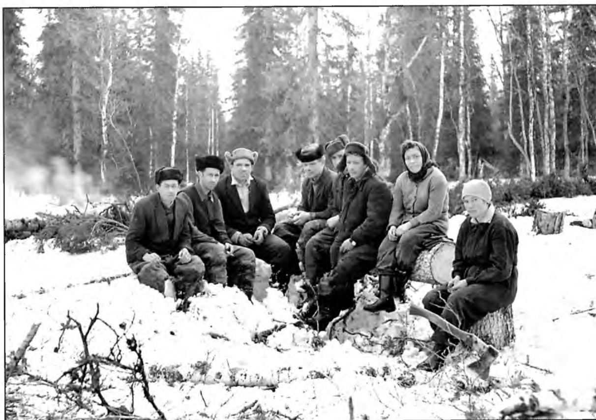
Бригада лесорубов на подготовке площадки для строительства обогатительной фабрики
