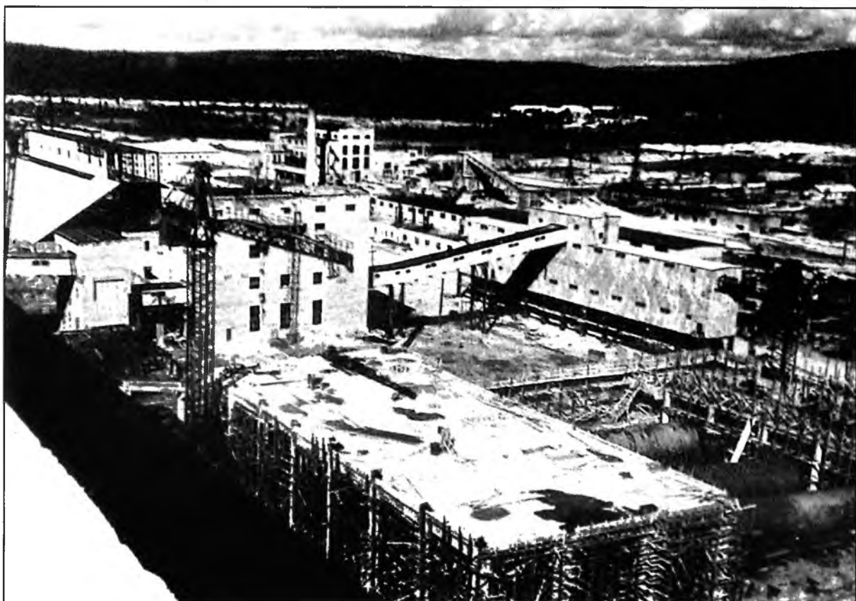
Строительство секции обогащения МОФ
