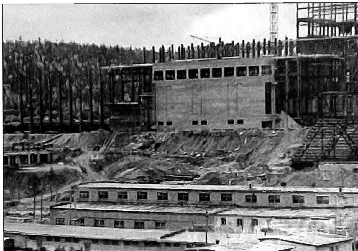
Строительство МОФ. 1960 г.
