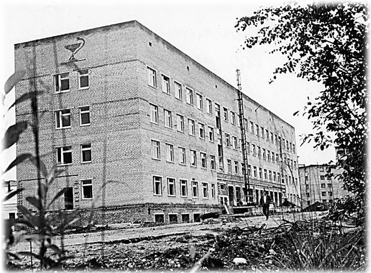
Строительство нового корпуса районной больницы
