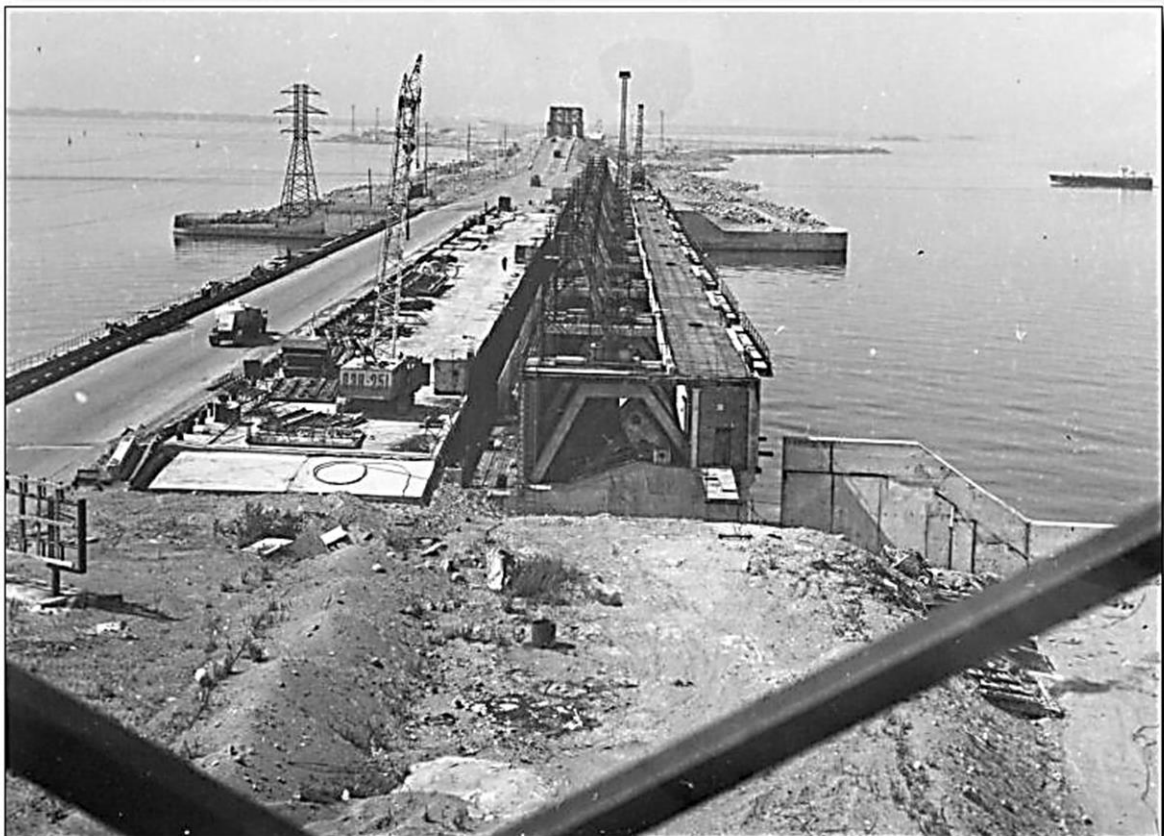
Строительство Ленинградской защитной дамбы
