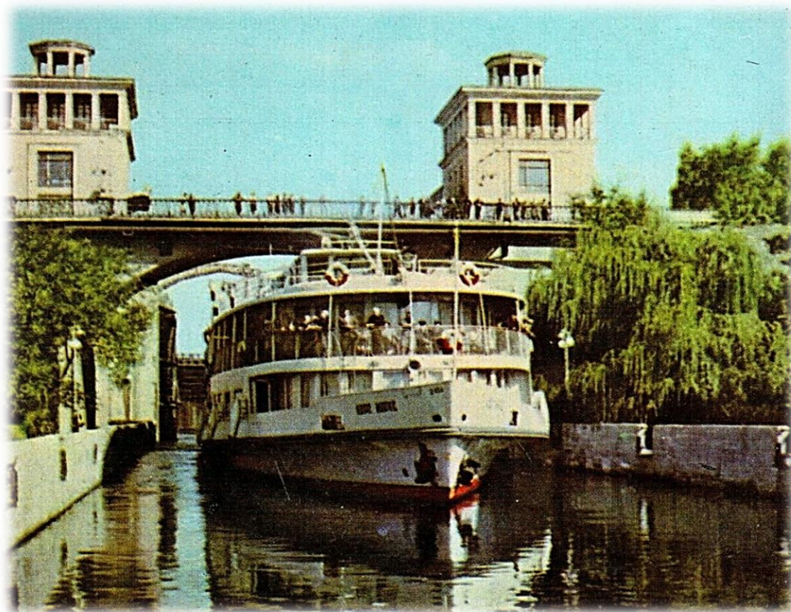
Шлюз на Днепрогэсе
