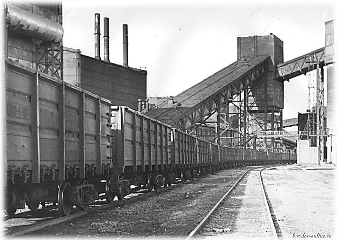
Вагоны подаются под погрузку железорудного концентрата.
