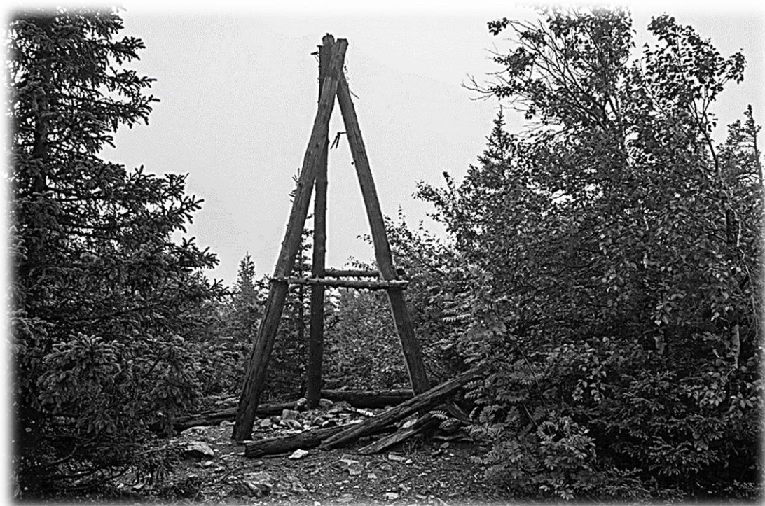
Временная опора под электропроводку.
