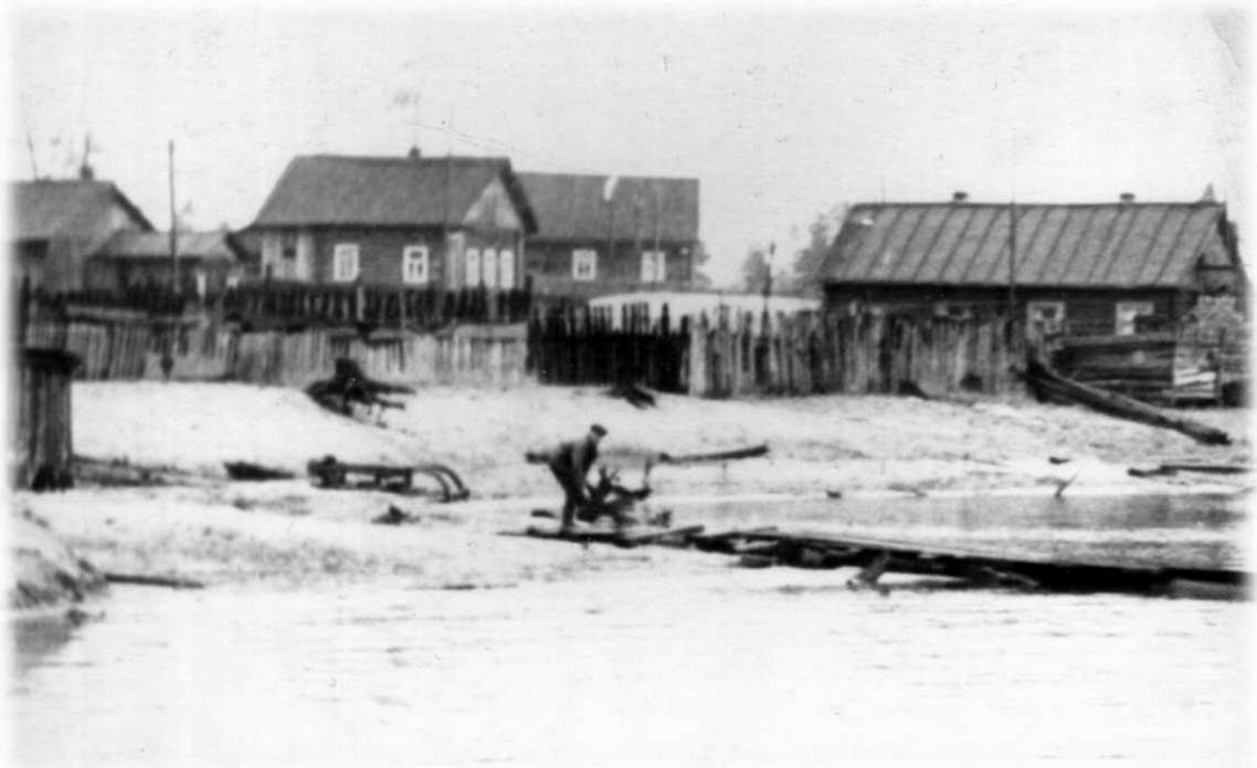
Ёна. Улица Приозёрная, рядом с электростанцией
