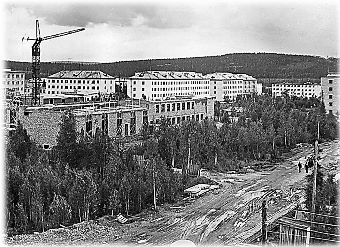
1965 год. Строительство ДК.
