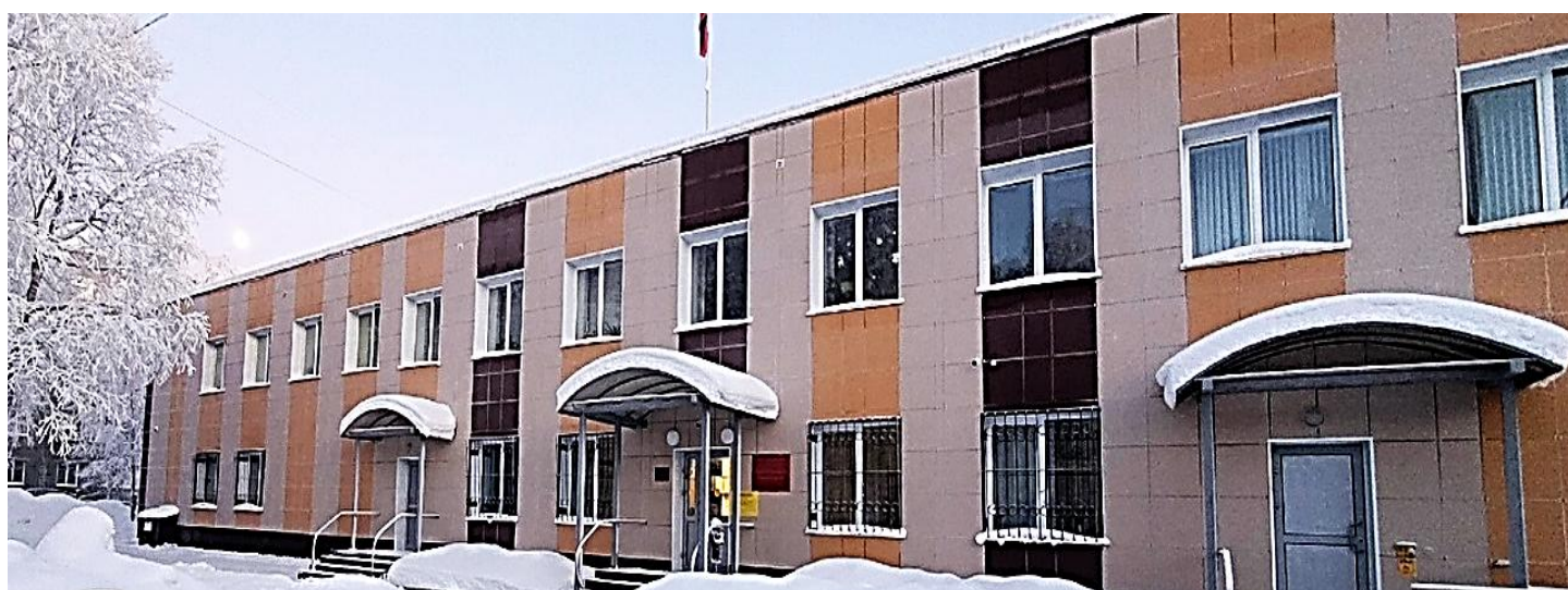
Здание Ковдорского районного суда
