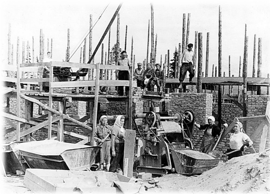
На строительстве обогатительной фабрики.
