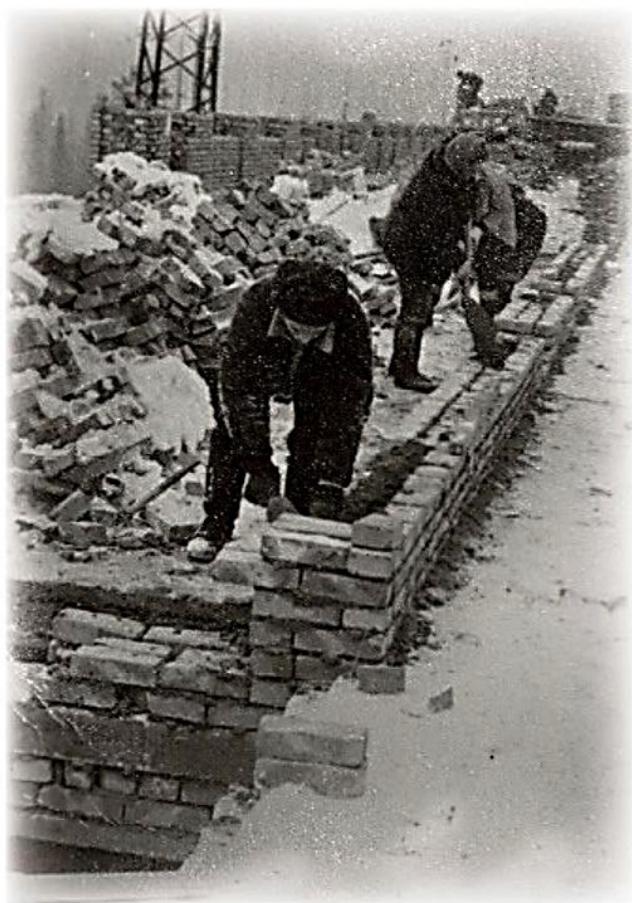
Кирпичи укладывали вручную...
