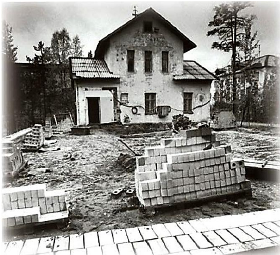
Строительство районного краеведческого музея
