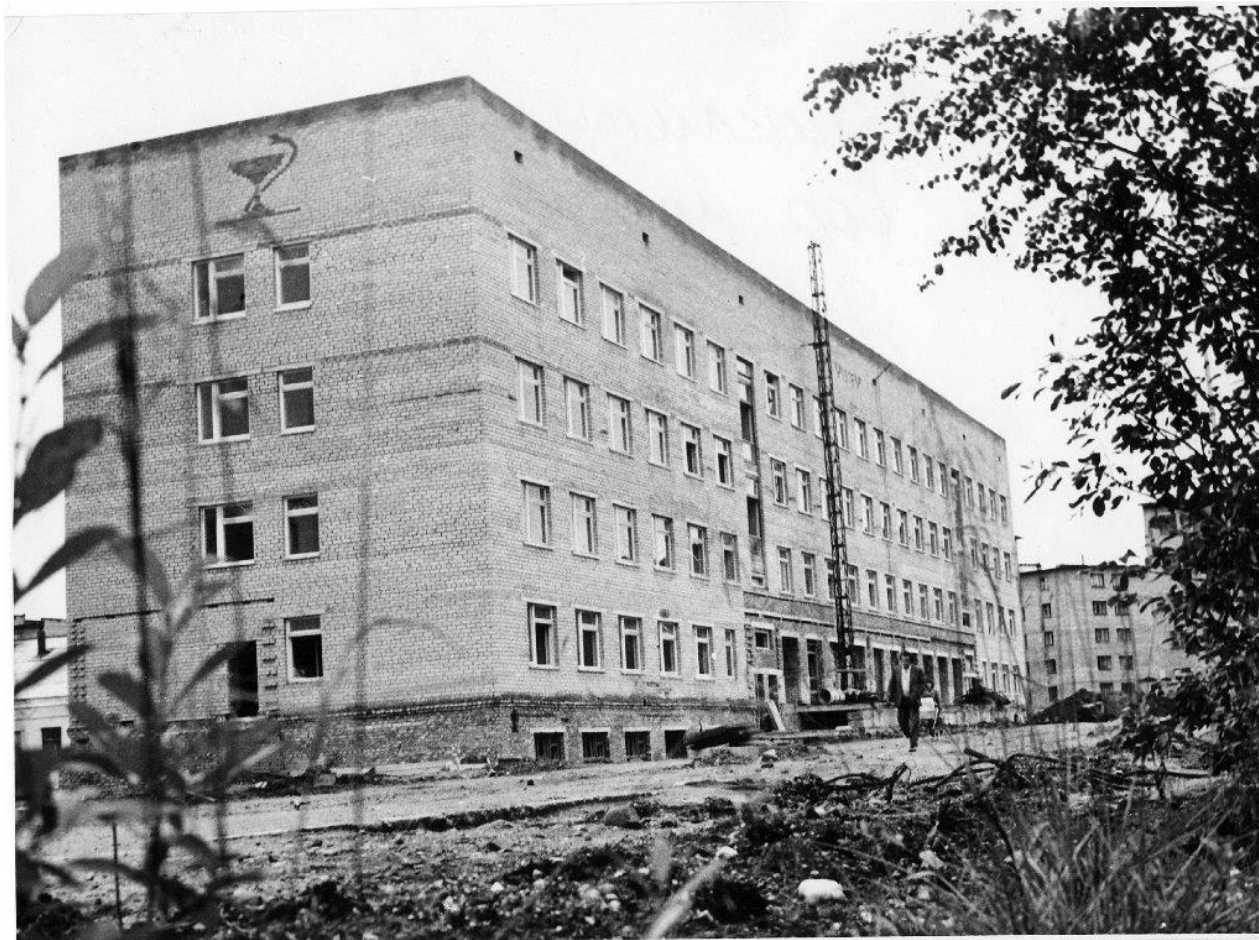
Строительство корпуса Ковдорской поликлиники (1976 г.)
