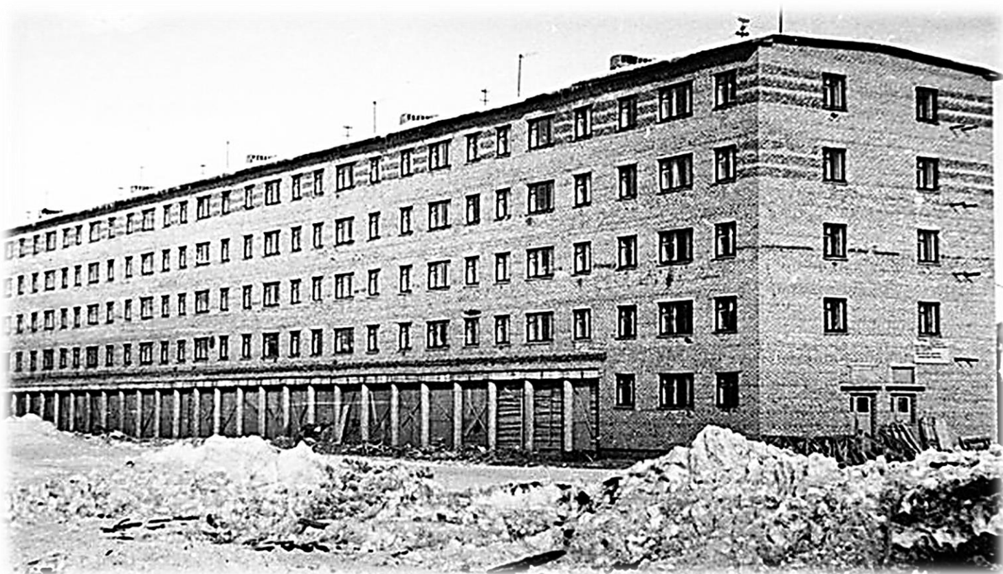
Строительство жилого дома на ул. Школьной в г. Ковдоре. 1960-1970 гг.
