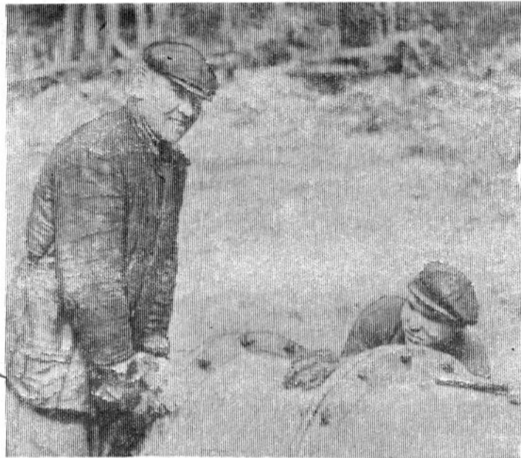
Пос. Ковдор. Горнообогатительный комбинат. Слесари хвостового хозяйства заботливо обслуживают оборудование и хвостопровод. На снимке (слева направо): Козлов П. М. и Безбородов В. А. производят переключение подачи хвостов с зимнего на летний сброс. Фото А. Александрова.
