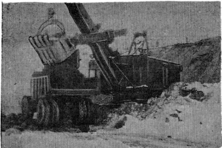
ПОСЕЛОК КОВДОР. Погрузка горной породы на руднике «Железный» экскаватором в автосамосвал. Фото машиниста сушильных барабанов Ж. Терещенко.
