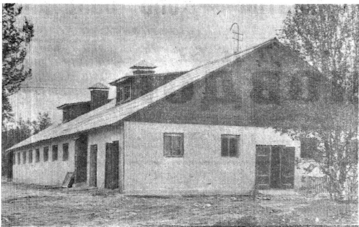
КОВДОР. Подсобное хозяйство орс горнообогатительного комбината в текущем году значительно расширяется. Уже закончено строительство конюшни и свинарника. На снимке: помещение свинарника на 300 голов.
