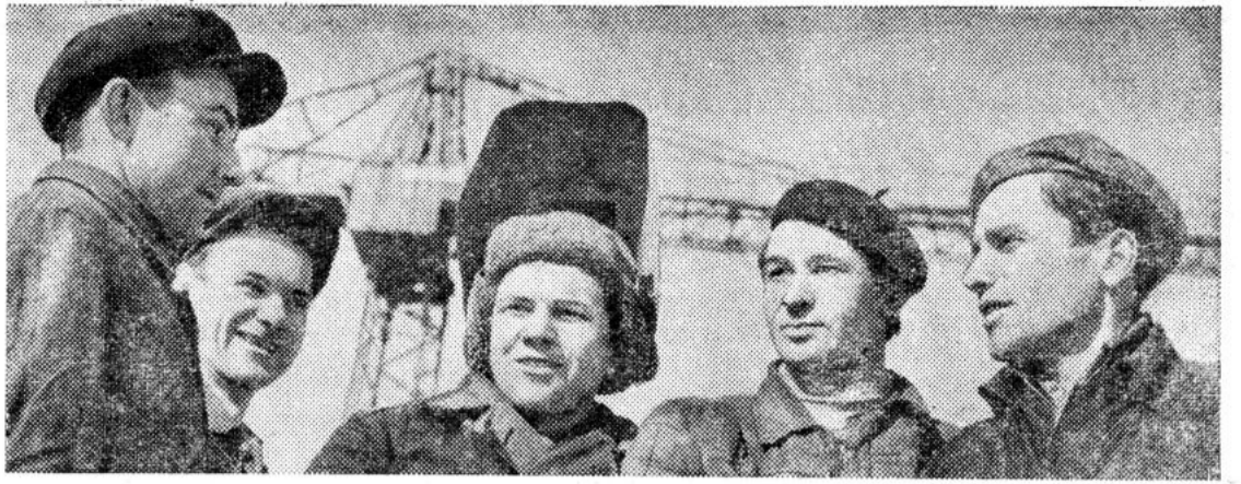
Строительство жилых домов в Ленинграде идет невиданными темпами. Коллектив Автовского домостроительного комбината обязался 50-квартирный дом возводить за 13 рабочих дней. Рекордных результатов добилась бригада коммунистического труда монтажников Ивана Пенгарта. 70-квартирный жилой дом она собрала за одиннадцать рабочих дней. На снимке: передовые монтажники бригады (слева направо) Павел Саматыя, Артем Шепелюк, Николай Андреев, Анатолий Чечкин и бригадир Иван Пенгарт. Фото М. Блохина. Фотохроника ТАСС
