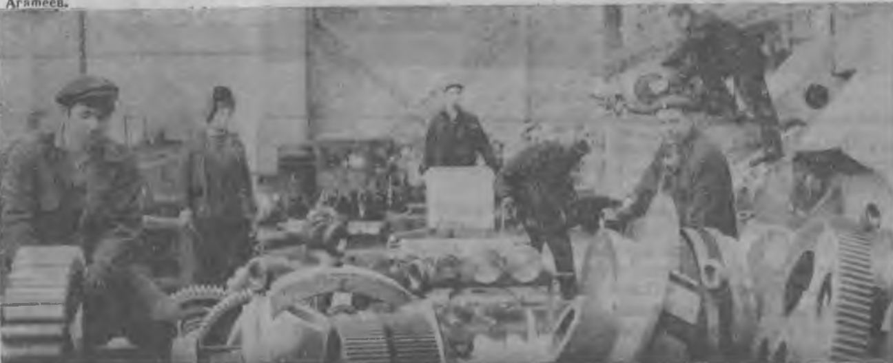
Пролет ремонтно-механического цеха.
