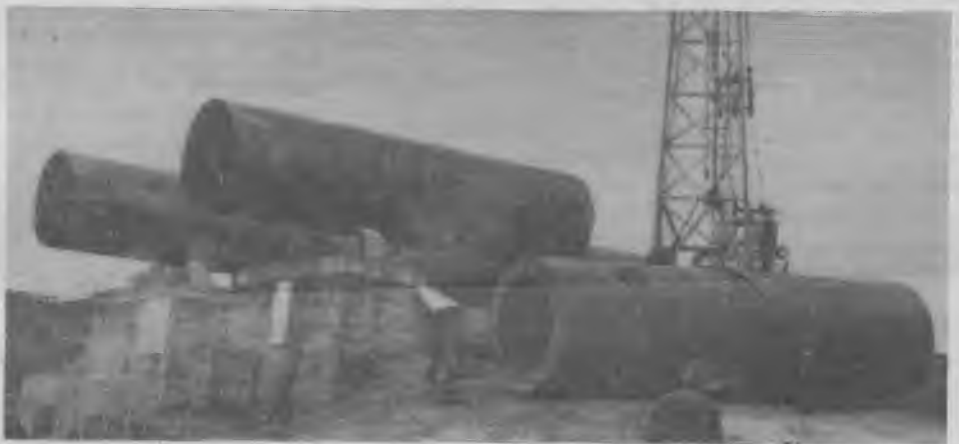
Только что закончена строповка секции второго барабана... Махину весом более 60 тонн монтажники бригады А. Цахаева и машинист крана Б. Зырский должны установить на опорные ролики, состыковать ее с первой секцией.
