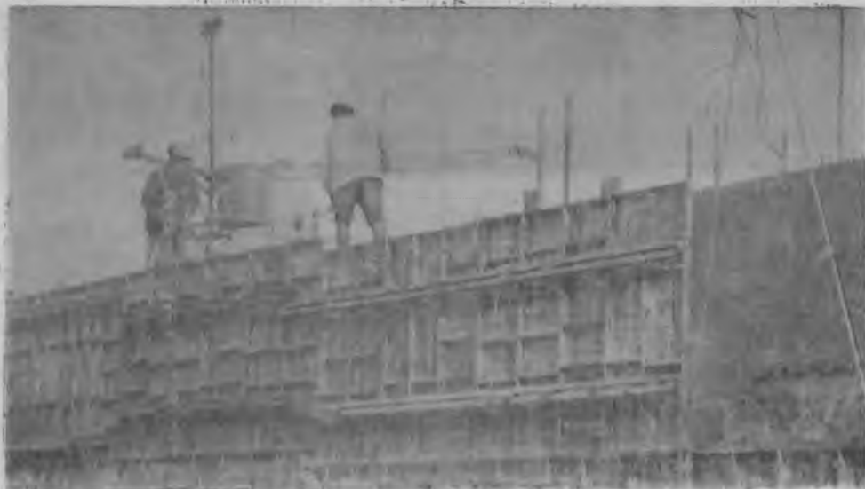
Бригады В. И. Горшкова и А. Ф. Даричева уложили в основание прямка по оси «Ж» корпуса обогащения АБОФ 150 кубометров бетона, смонтировали 300 квадратных метров опалубки, связали 12 тонн арматуры.
