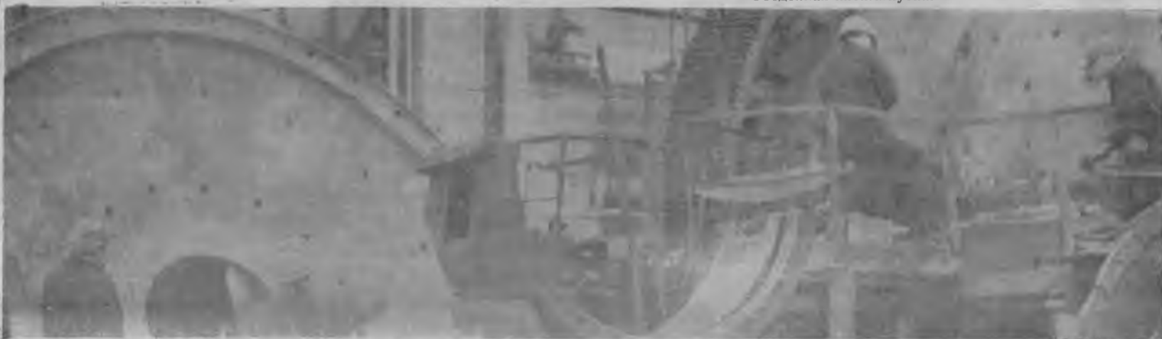
Участок обогащения. Ремонтируют мельницу.
